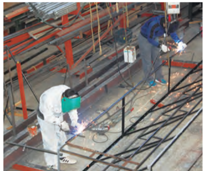
自社工場での溶接作業風景
