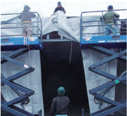
大型テント倉庫の施工現場
